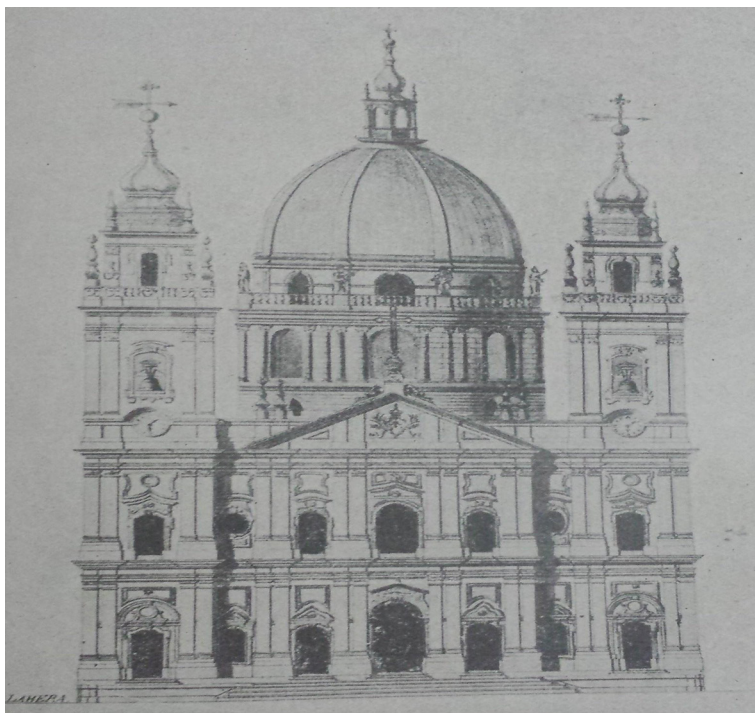
Figura 2- Imagem da Candelária em fase final de sua construção: Fonte: Pinheiro, 1930, p. 91.
