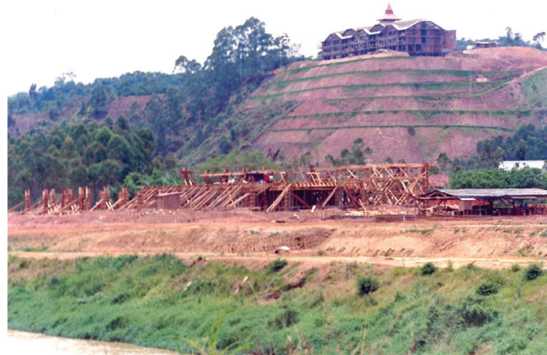
Figura 3: Rodoviária, Beira-Rio e Hotel Monthez. Flagrante das obras do Hotel Monthez no topo do morro (construído entre 1987 e 1992), do terminal Rodoviário e Avenida Beira Rio. A foto compõe o Relatório de situação e obra do Terminal Rodoviário de Brusque em 16 de março de 1990.
