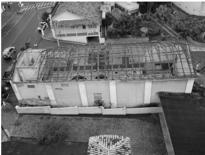
**Figura 5.** Cine Teatro Verane visto de cima. O telhado já havia sido retirado para a demolição.
