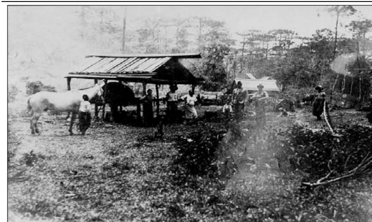
Figura 1. Trabalhadores que atuaram na construção da estrada entre Xaxim e Ponte Serrada (15 dez. 1937)
