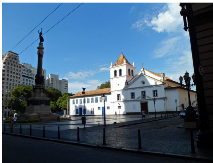
Figura 1 – O conjunto colégio-igreja no Pateo do Collegio
