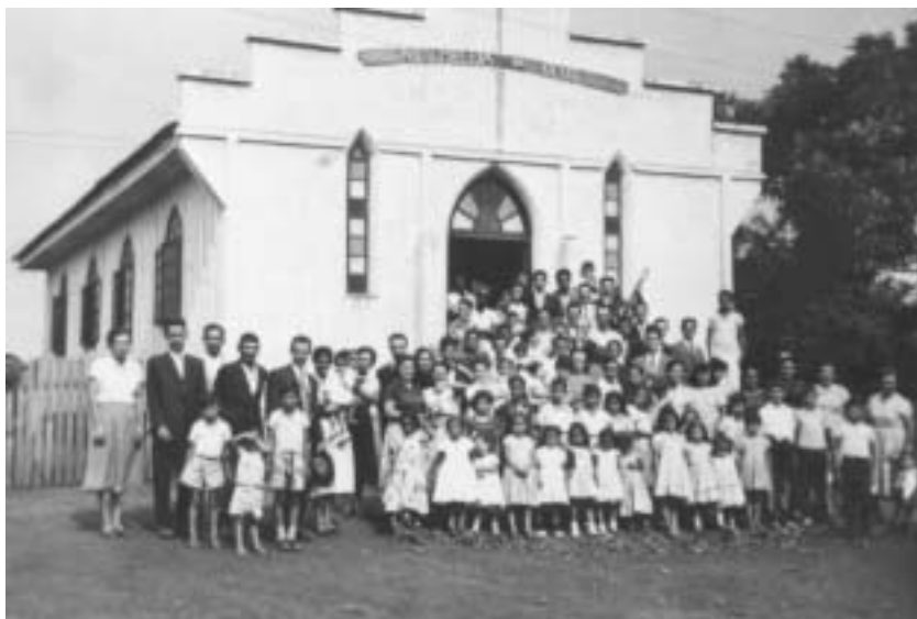
Fachada em alvenaria da Igreja 27
