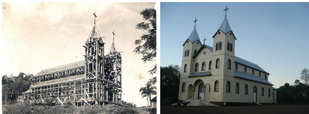
Figura 2 – Foto da Igreja São Rafael sendo construída em 1952 e seu aspecto contemporâneo. Arquitetura em madeira.
