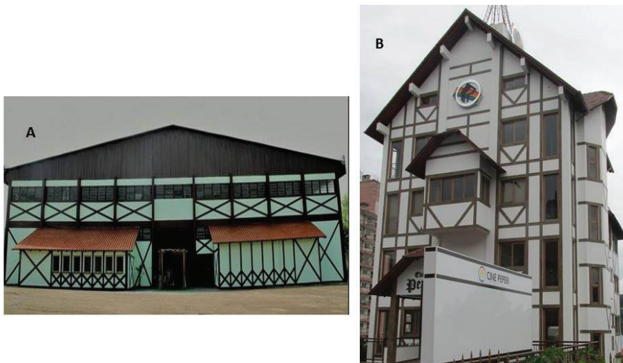
Figura 12 – Edificações com referência à linguagem enxaimel: Complexo da Oktoberfest (A) e Edifício Rádio Peperi (B).
