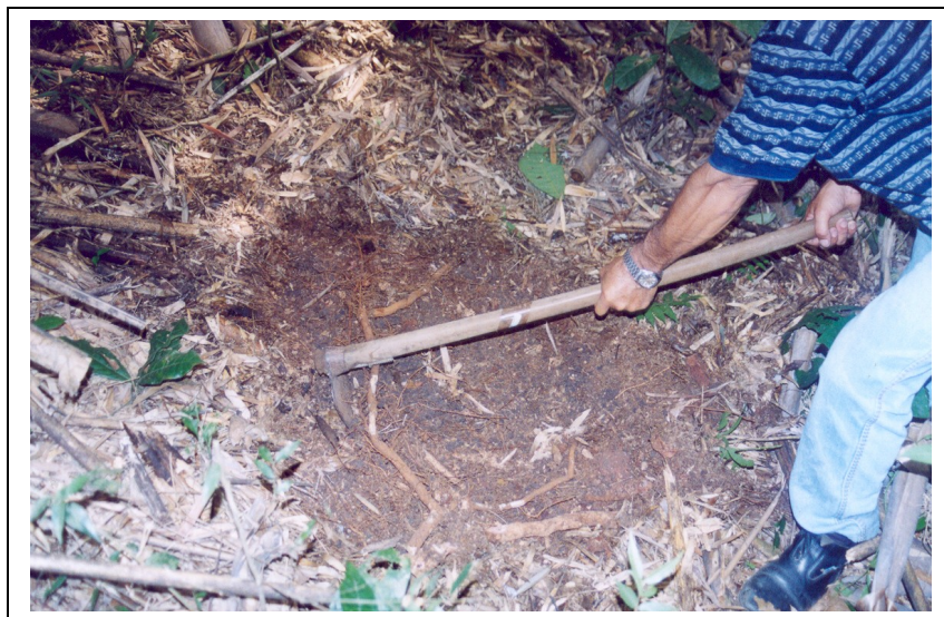
Limpeza da superfície no ponto T1G, Bota-fora "C".
