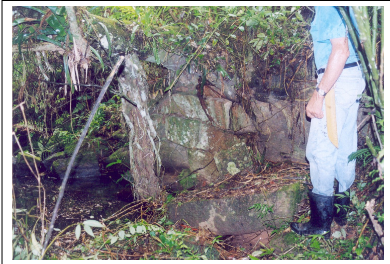
Estrutura de pedra (murro de arrimo) construído na margem do córrego.
