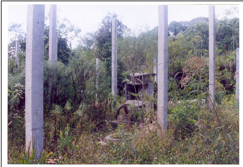
Vista geral do maquinário do engenho abandonado em antigo galpão desmontado.
